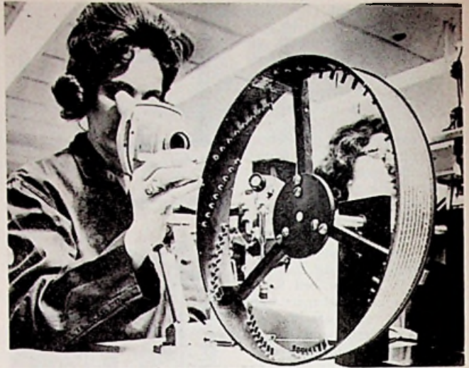
General Electric gebruikt voor de massa-productie van halfgeleiders dit wiel, voorzien van tape, waarop ruim 1000 chips, het hart van de transistor. Mijnsen - stand 35
